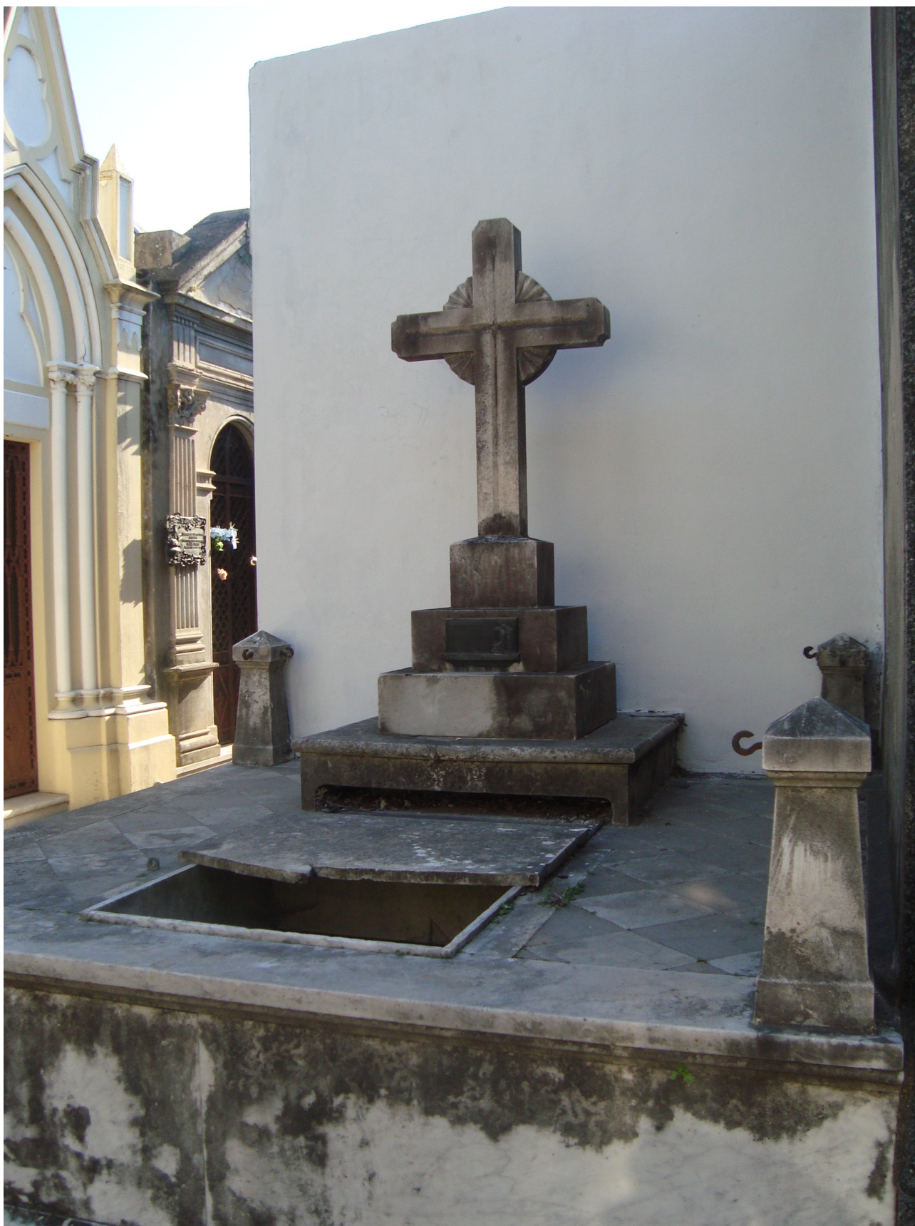
FOTO 4. Bóveda con la tapa quebrada en cuyo interior las personas tiran basura (ver foto siguiente)
