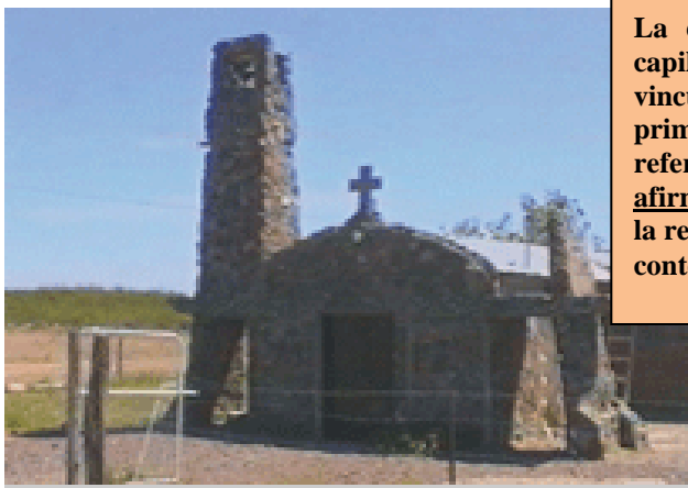
24. Capilla antes de la intervención
