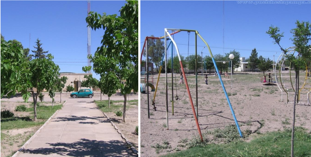
13 y 14. Imágenes de la remodelación de la Plaza Central de puelches
