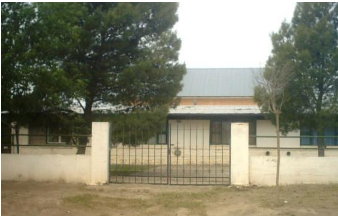
20. Frente de la antigua escuela N°102 de Puelches, provincia de La Pampa
