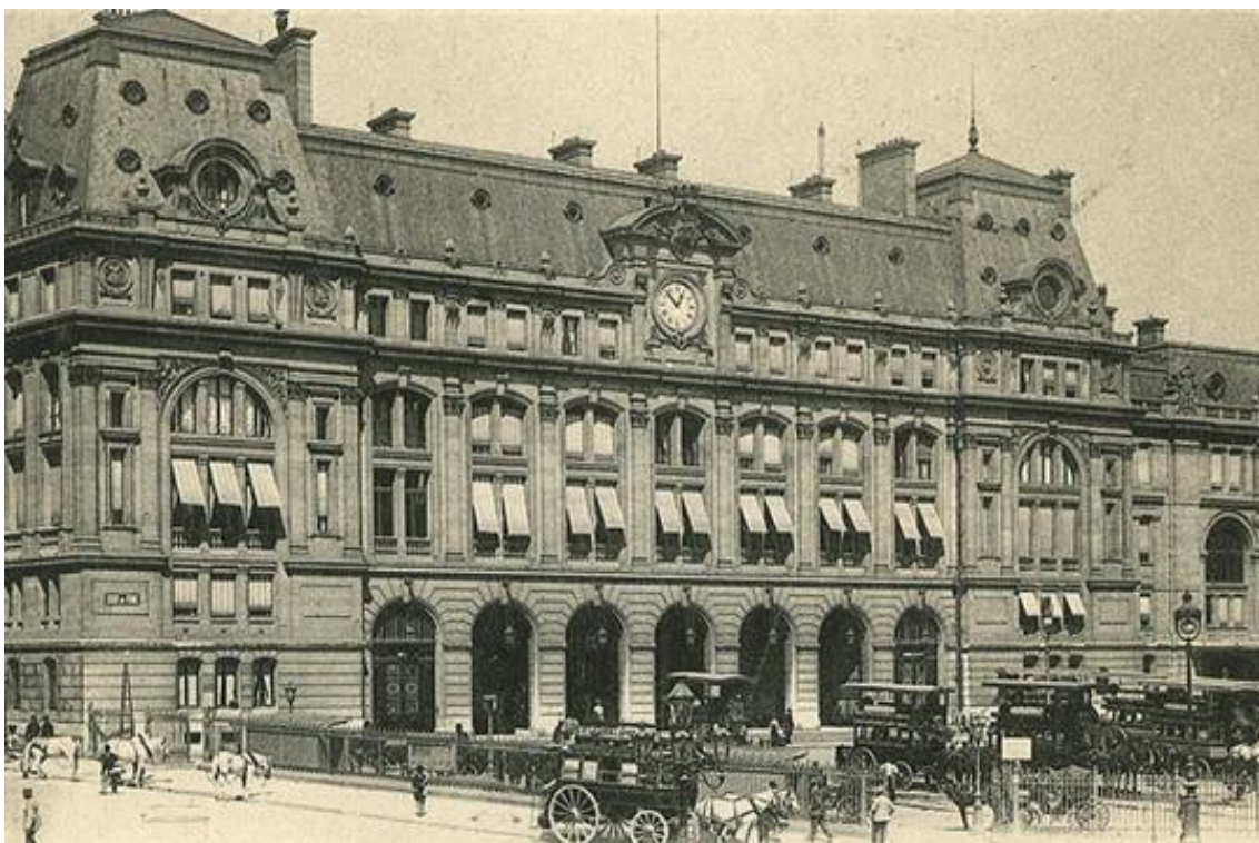
Estación de Paris Saint-Lazare.
