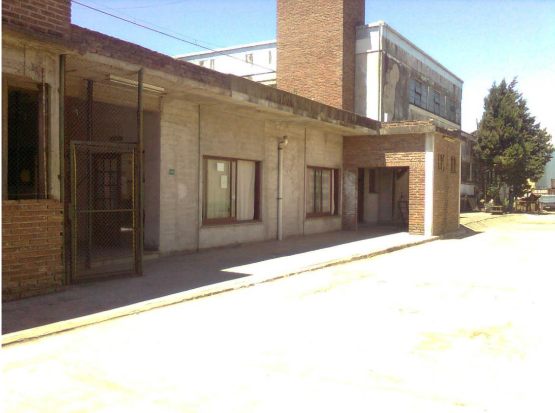
Aula de 2do año vista desde el patio de recreos. Al fondo a la derecha se ve el edificio de la fábrica recuperada.
