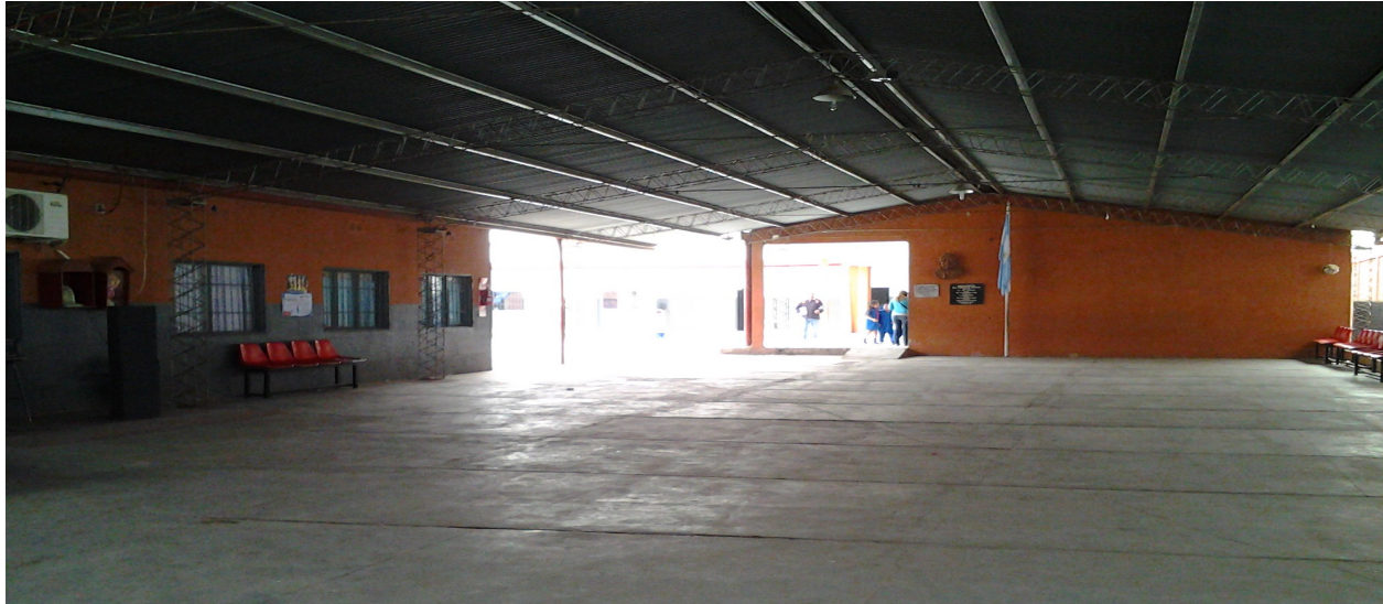
Patio de una de las escuelas del barrio Banda del Río Sali
